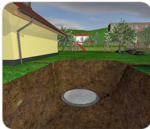
фиг.а2) Подложен бетон
