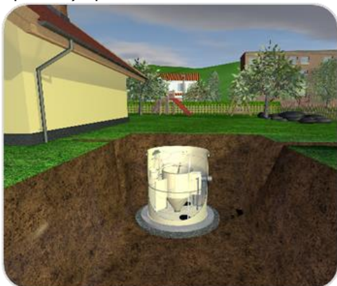
фиг. а3) Поставяне на ПСОВ върху бетона
